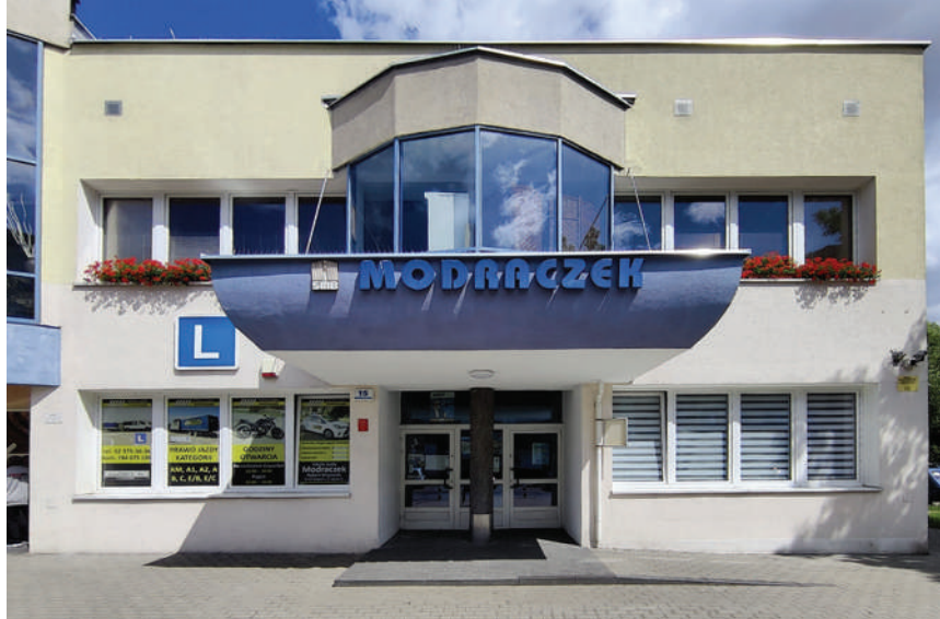
Dom Kultury „Modraczek” Spółdzielni Mieszkaniowej „Budowlani” w Bydgoszczy
